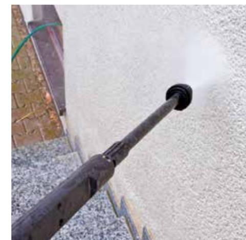
Lo sporco presente e le parti non adese vanno rimosse, provvedendo poi alla pulizia della muratura, tramite idrolavaggio a bassa pressione.
